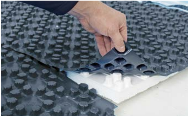
Kombinacija polistirenskog izolacijskog sloja i crne sistemske ploče
