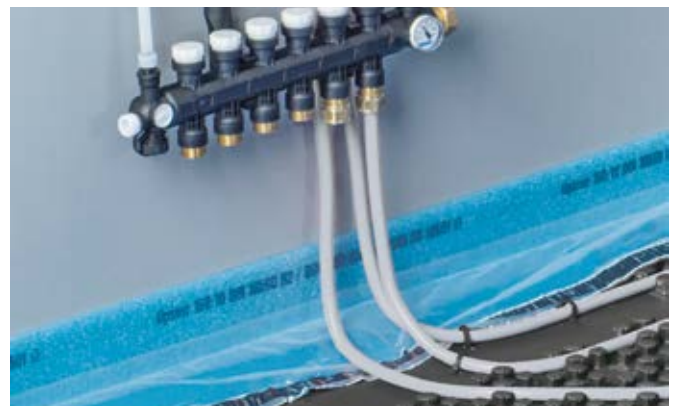
Učvršćivanje cijevi u distribucijskim područjima
